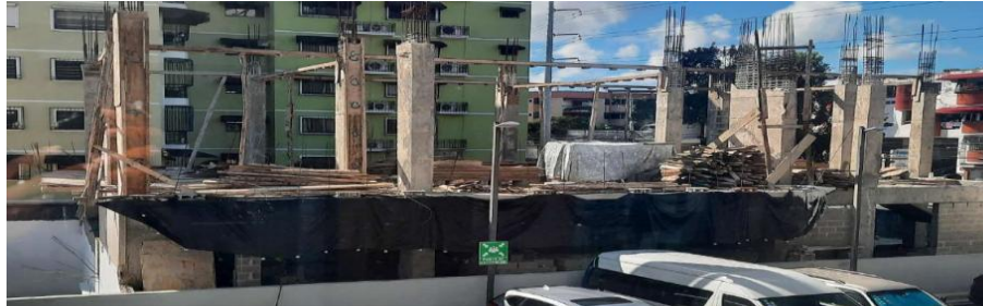
Figura n.º 11. Construcción del edificio escuela previsual y parqueo soterrado.
